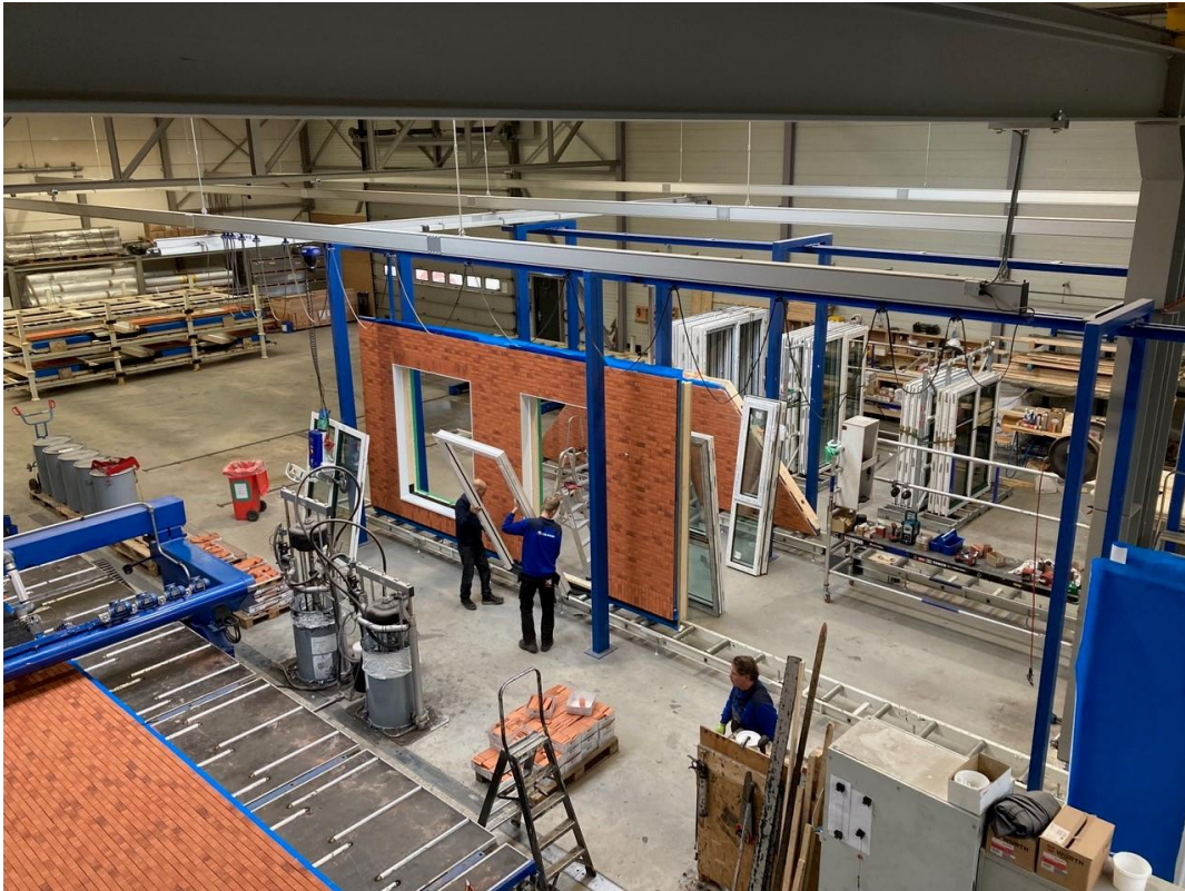
Industriële woningbouw in de fabriek van bouwgroep Dijkstra Draisma in Dokkum
